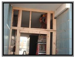
Seabee installing door frame.
