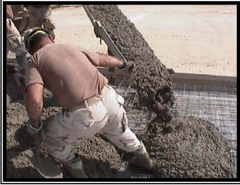
CE2 Caetano places concrete.
