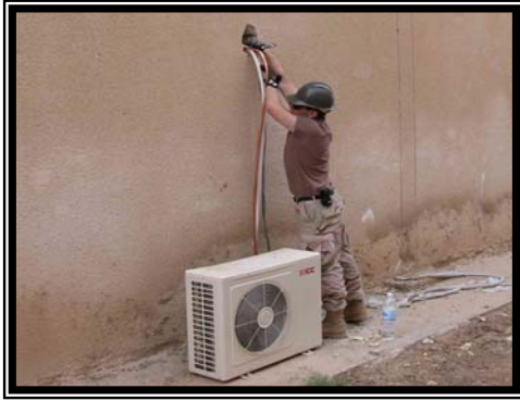
UT2 Golladay installs an A/C unit.
