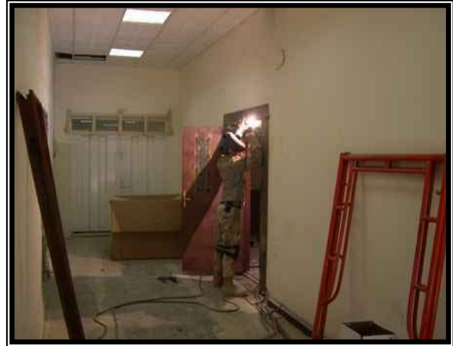
A Seabee welds a door frame.
