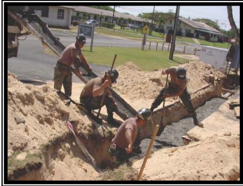
Encasement of electrical conduit.
