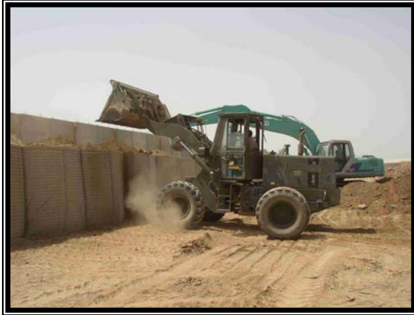
Seabees fill HESCO barriers.
