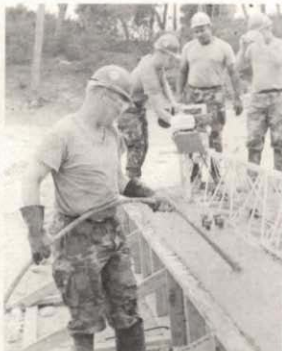
Another pour for the MWR warehouse
