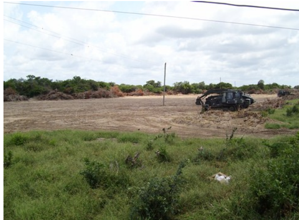
2.75 Acre Jungle Clearing for CESE Lay down
