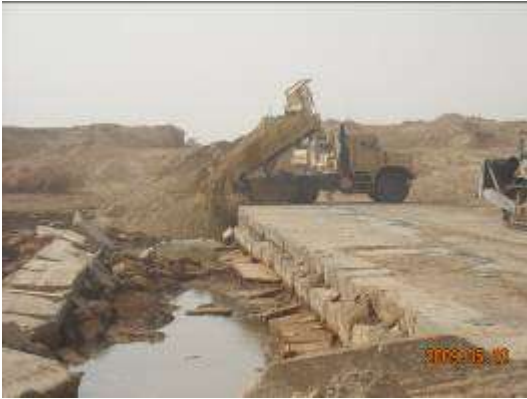
MTVR Dump pours dirt for Embankment
