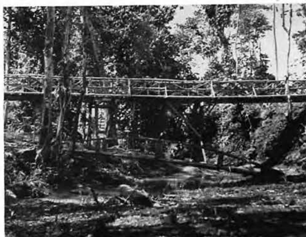
BRIDGE TO B. O. Q.
