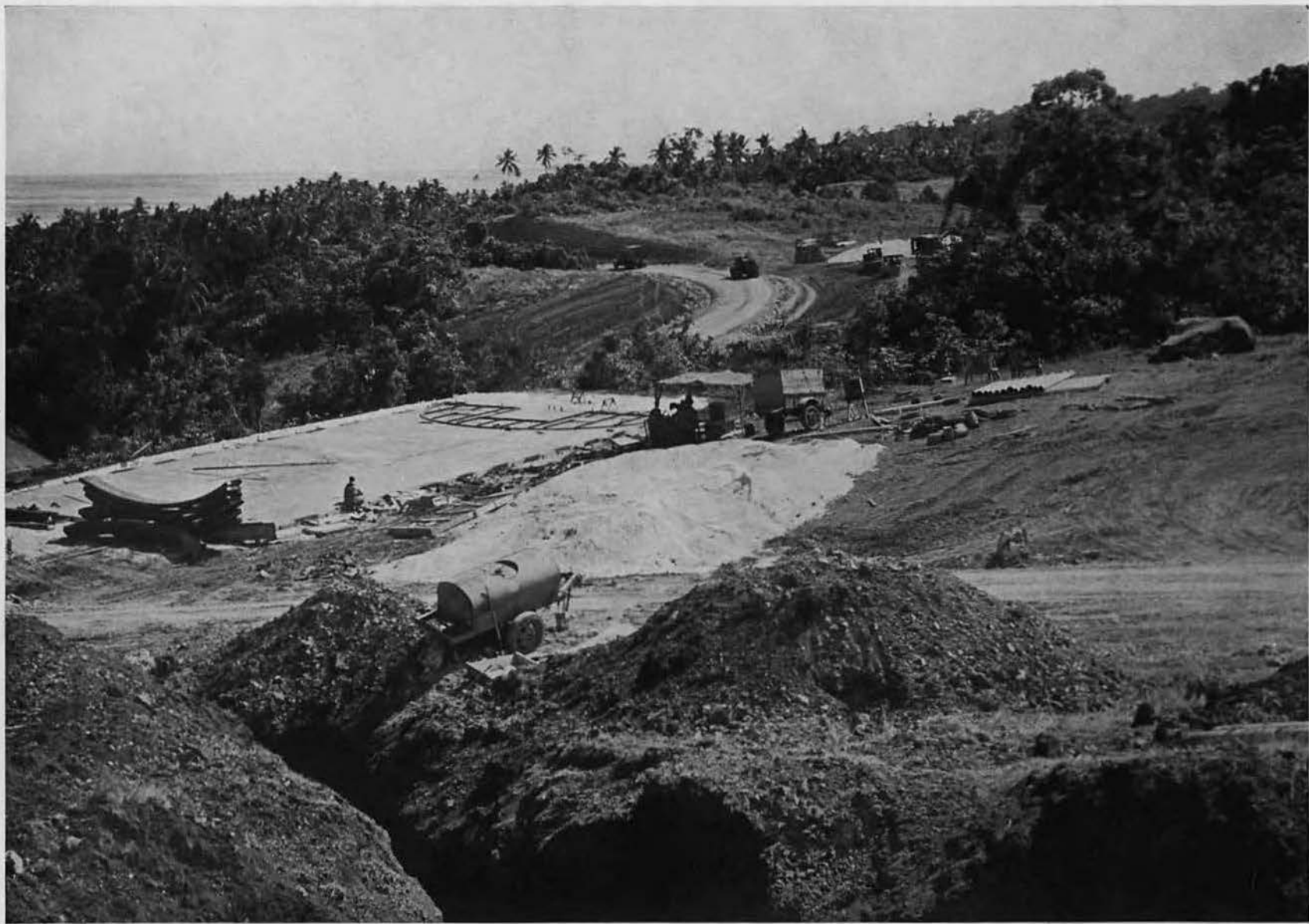
N. A. D. Camp Area Project
